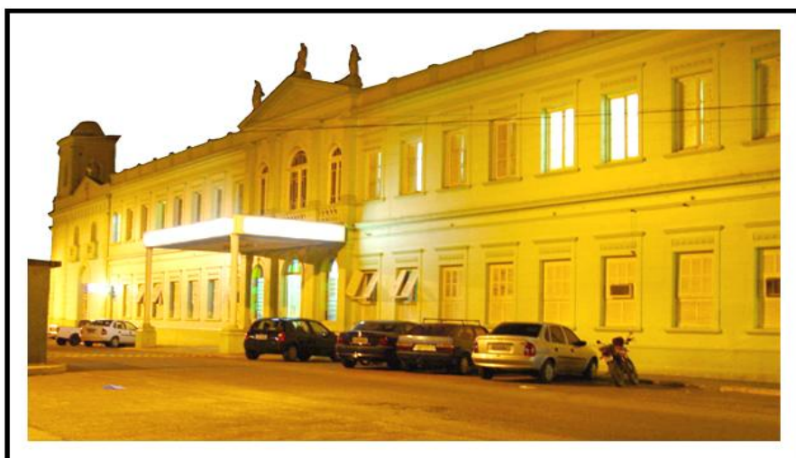
Fachada da Irmandade da Santa Casa de Caridade de São Gabriel
