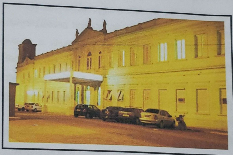
Fachada da Irmandade da Santa Casa de Caridade de São Gabriel
